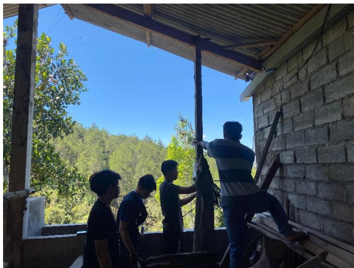
Gambar 4. 4. Proses pemasangan alat.
