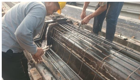
Gambar 3. 8 Pengikatan besi dengan kawat bendrat
