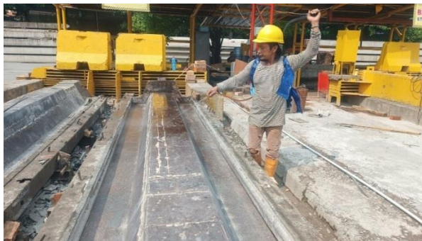
Gambar 3. 3 Penyemprotan Minyak Bekisting
