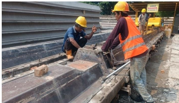
Gambar 3. 2 Meletakan separator cetakan
