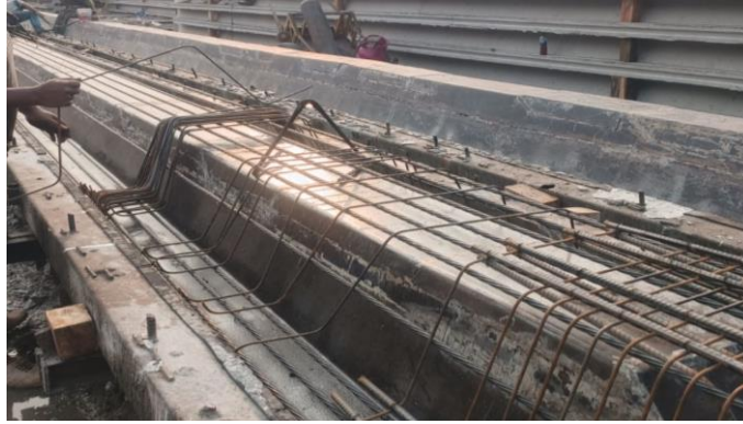
Gambar 3. 9 Pemasangan handling loop
