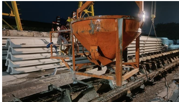
Gambar 3. 12 Penuangan beton
