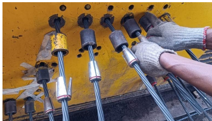
Gambar 3. 6 Pemasangan Wedges dan Barel
