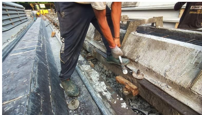
Gambar 3. 11 Pemasangan wing nut
