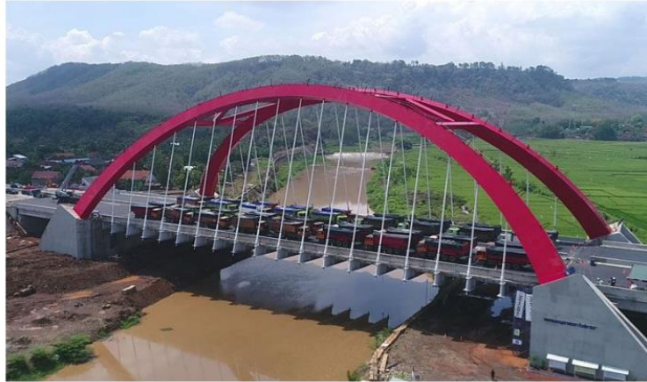
Gambar 2.5 Jembatan Lengkung (Arch Bridge) Jembatan Tol di Kendal
