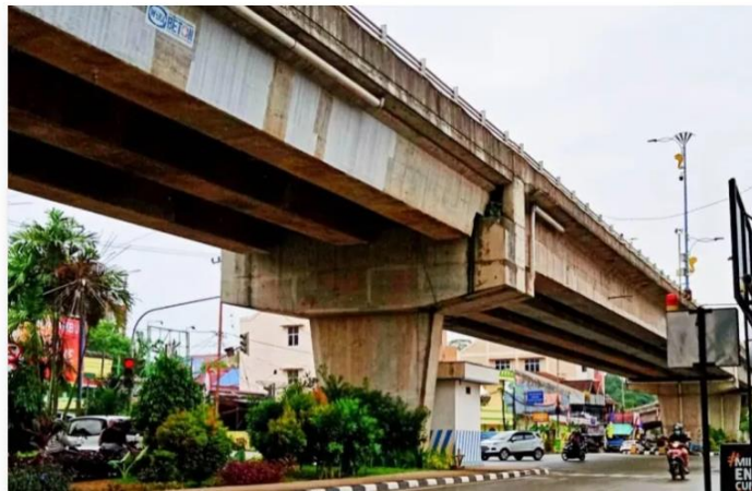
Gambar 2.3 Jembatan Gelagar (Beam Bridge) di Samarinda
