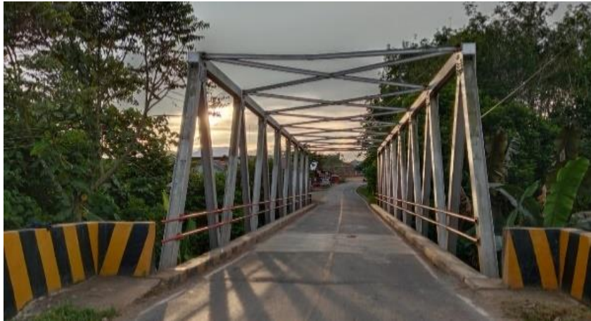
Gambar 2.1 (Truss Bridge) Jembatan Rangka di Muara Wahau . Kutai Timur
