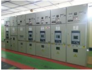
Gambar 1. Kubikel Tegangan Menengah [9]
