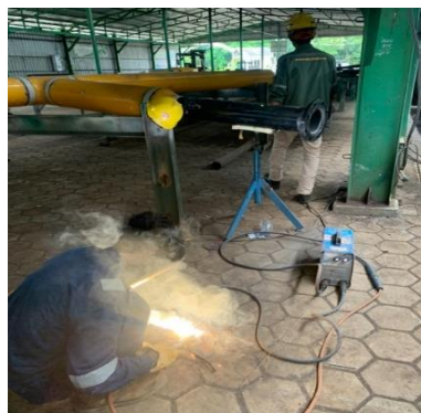
Gambar 1 : Proses pengelasan posisi 1G.
