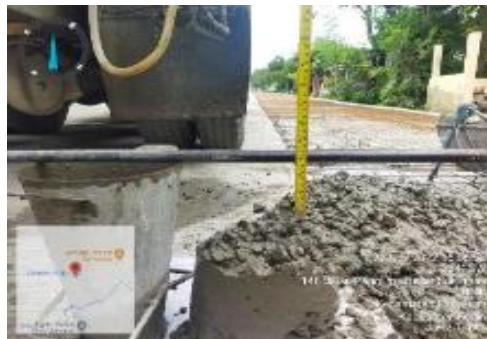
Gambar 12 Uji Tes Slump
