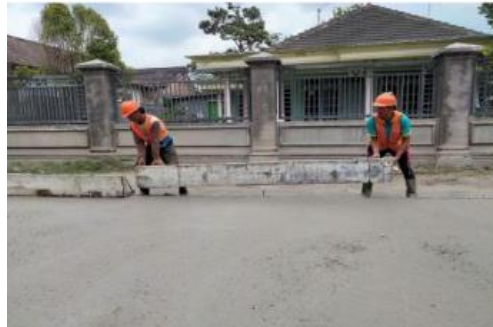
Gambar 5 Pekerjaan Bekisting
