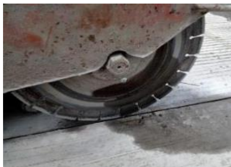
Gambar 15 Pekerjaan Cutting Beton
