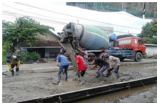
Gambar 6 Pekerjaan untuk Lean Concrete
