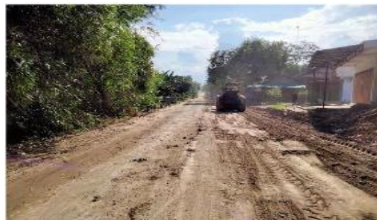
Gambar 3 Pekerjaan Cut and Fill
