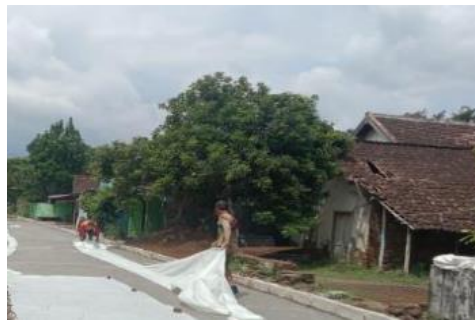
Gambar 7 Pekerjaan Pemasangan Plastik Cor
