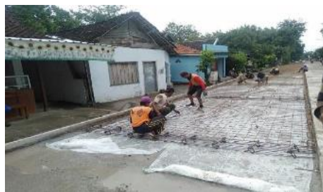
Gambar 10 Pemasangan Dowel Bar
