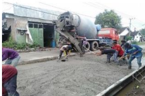
Gambar 11 Pekerjaan Pengecoran
