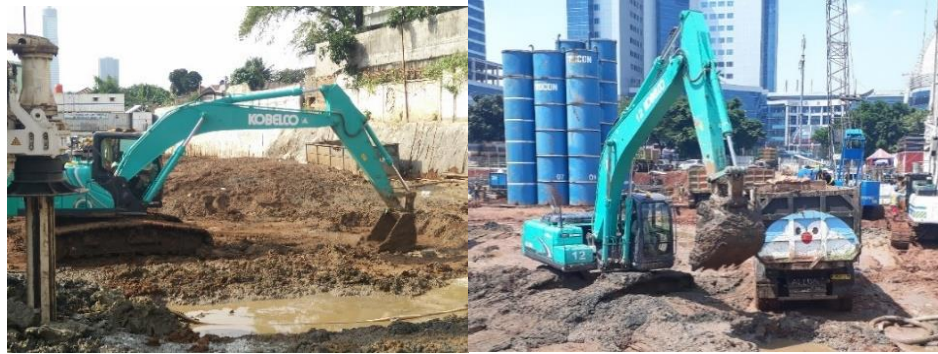
Gambar 20. Proses Pembersihan Lumpur dengan Excavator kemudian Dibuang dengan Dump Truck lalu dilakukan pengurukan Kembali lubang borepile
