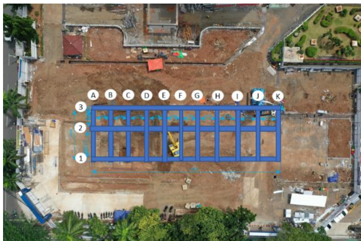
Gambar 4. Survey Pondasi Beton Bertulang Eksisting sebelum Pembongkaran Dilakukan (Sumber : Arsip Data PT. PP)
