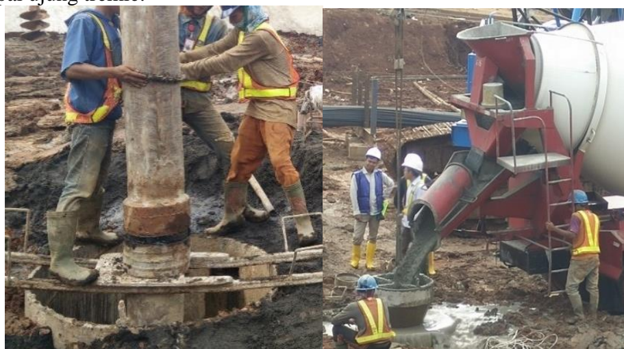
. Gambar 19. (Kiri) Pemasangan Tremie (Kanan) Pengecoran
