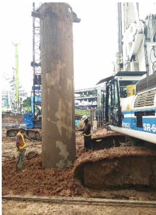
Gambar 14. Pemasangan Casing Borepile
