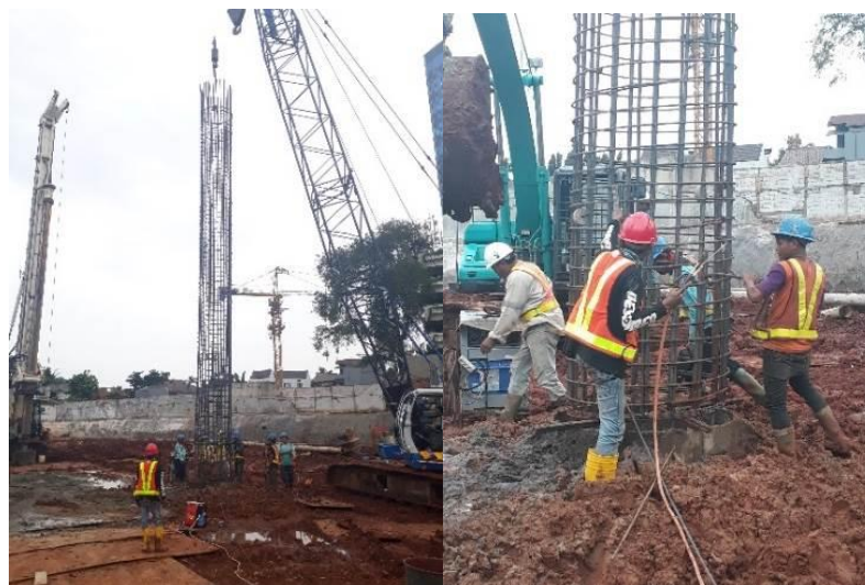
Gambar 18. (Kiri) Pengangkatan Segmen Besi Borepile dengan Service Crane dan (Kanan) Pengelasan antar Segmen Besi Borepile
