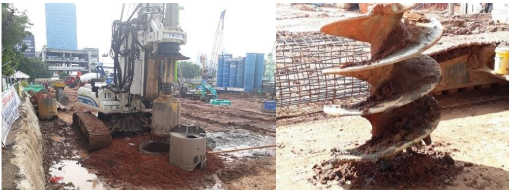
Gambar 13. Pekerjaan Preboring
