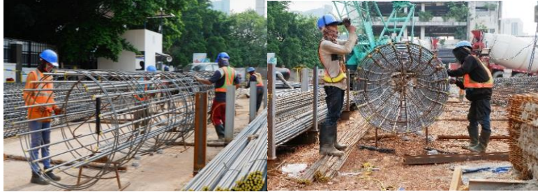
Gambar 12. Proses Fabrikasi Tulangan Borepile
