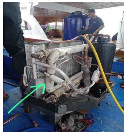
Gambar 4.4 Pemasangan Kondensor
