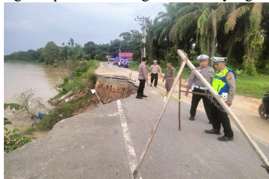
Gambar 2: Jalan di Desa Petalongan terdampak abrasi. Sumber
