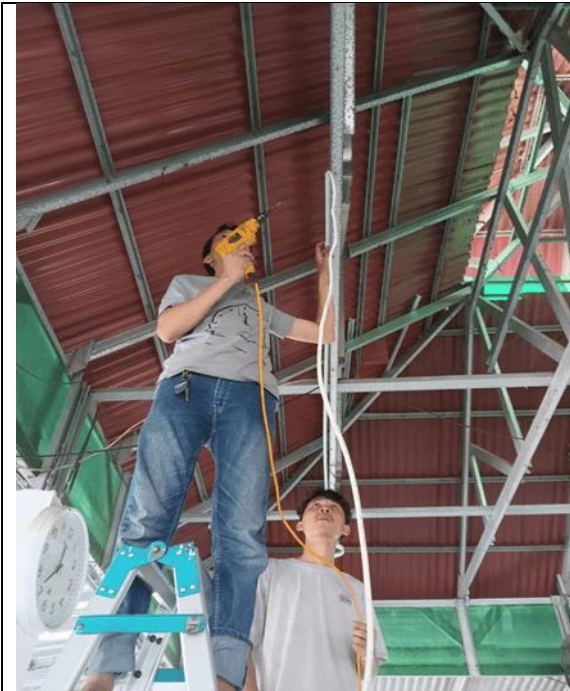
gambar1 17 Proses pengeboran untuk klem instalasi
