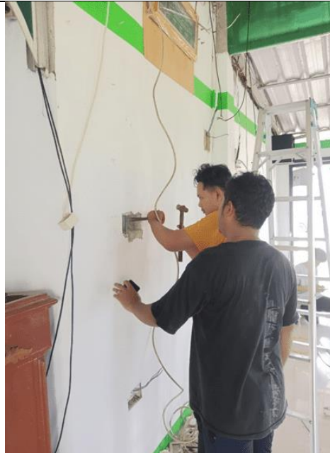
gambar1 14 Proses pembobokan tembok untuk saklar dan stopkontak
