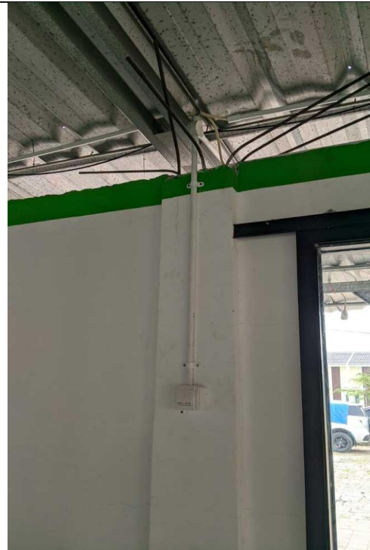
gambar1 27 Penambahan Saklar Untuk Area Teras
