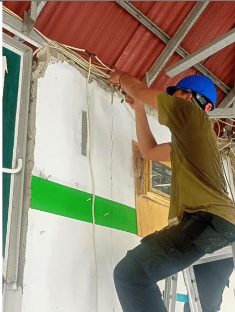
gambar1 13 proses pembongkaran instalasi
