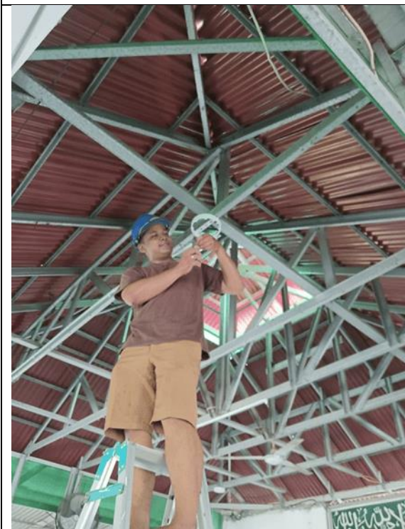
gambar1 19 Proses pemasangan lampu
