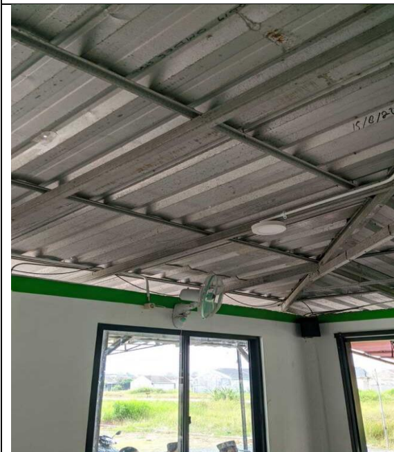
gambar1 28 Hasil Pengerjaan lampu dan Instalasi Area Wanita
