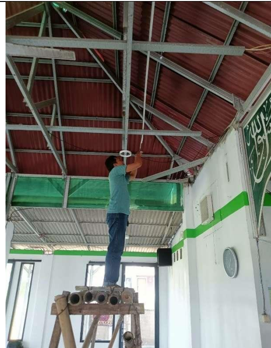
gambar1 18 Proses pemipaan instalasi penerangan
