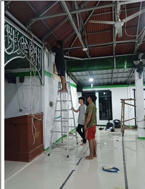
gambar1 24 Proses penyambungan dan merapikan Instalasi
