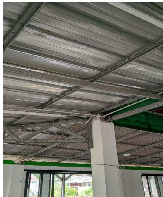
gambar1 29 Hasil Pengerjaan Instalasi di Area Wanita lainnya
