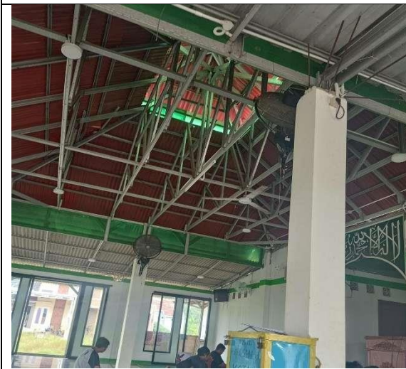
gambar1 32 Hasil Instalasi Area tengah
