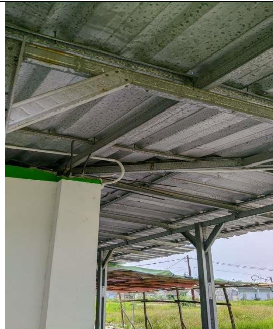
gambar1 31 Hasil Instalasi Bagian Teras lainnya
