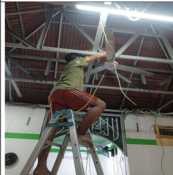
gambar1 22 Penarikan Kabel instalasi lama dan penarikan stop kontak suply CCTV
