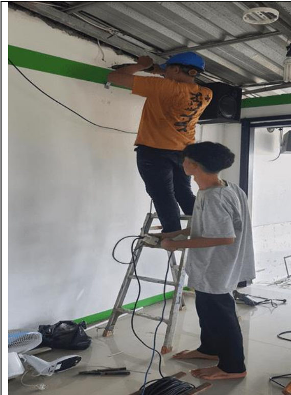
gambar1 15 Proses pengeboran untuk pemipaan instalasi
