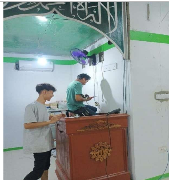
gambar1 233 Proses Pemasangan Stopkontak suplay AC
