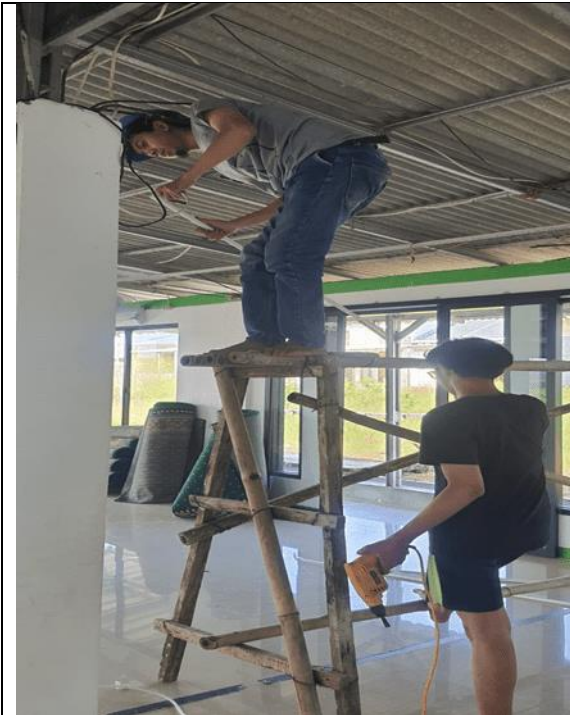
gambar1 20 Proses Pemasangan Instalasi stopkontak di area sholat Wanita
