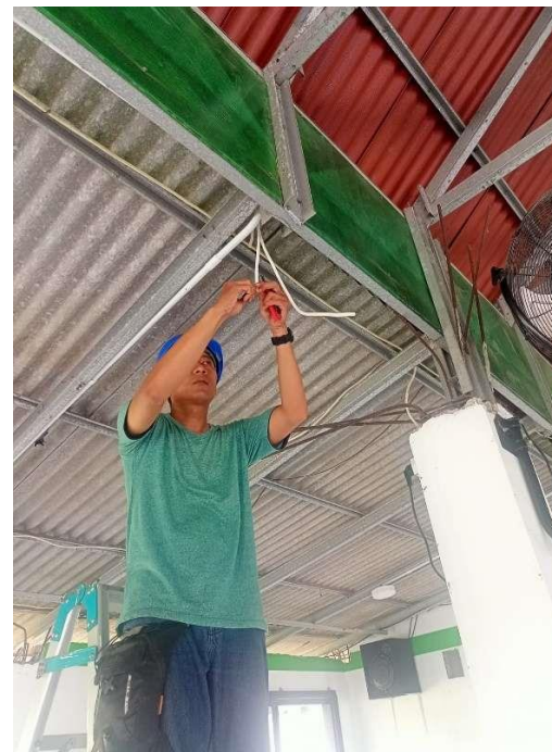
Gambar 5.9 Proses penyambunag Instalasi Penerangan
