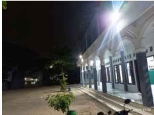
Gambar 7. Setelah penambahan Penerangan area depan Masjid
