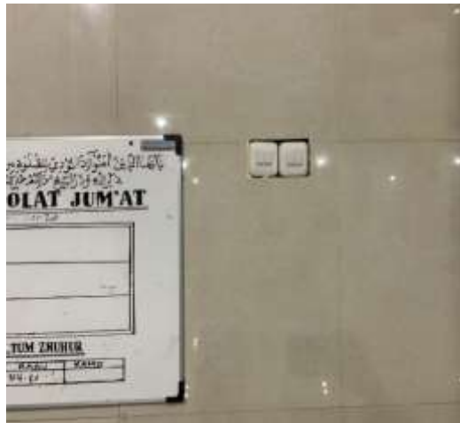
Gambar 10. Setelah Pergantian Saklar Lampu
