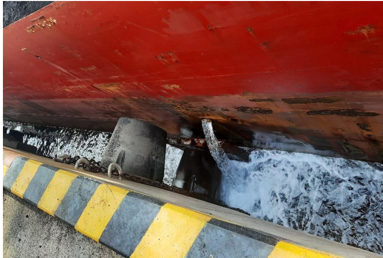
Gambar 4.2 fender jetty Pelabuhan PLTU Celukan Bawang Sumber: dokumen Pribadi
