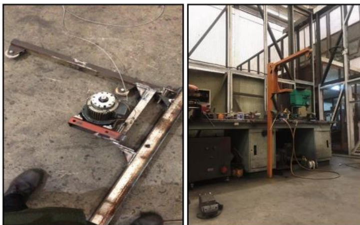
Gambar 6. Proses Pemasangan Pulley, Tali Baja dan Pengecatan
